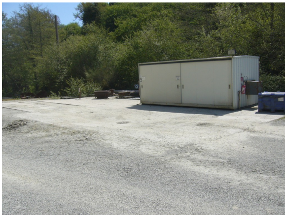
Zone de rétention des huiles et aire étanche de lavage des engins
