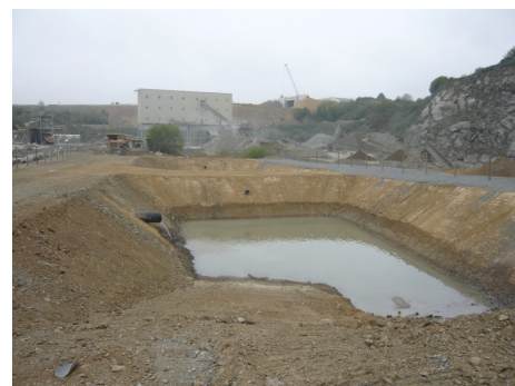
Création de bassins de décantation
