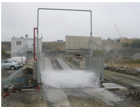
Décrocteur et rampe d'aspersion située avant la bascule
